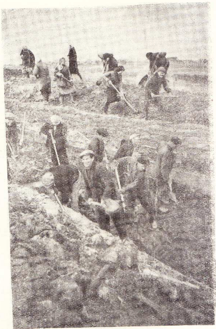
Враг — у зорот города. Героическая молодежь Ленинграда сооружает мощные противотанковые укрепления, чтобы преградить путь немецким захватчикам.
