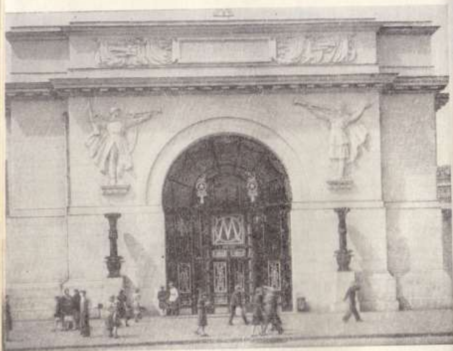
Станция метро «Октябрьская»
