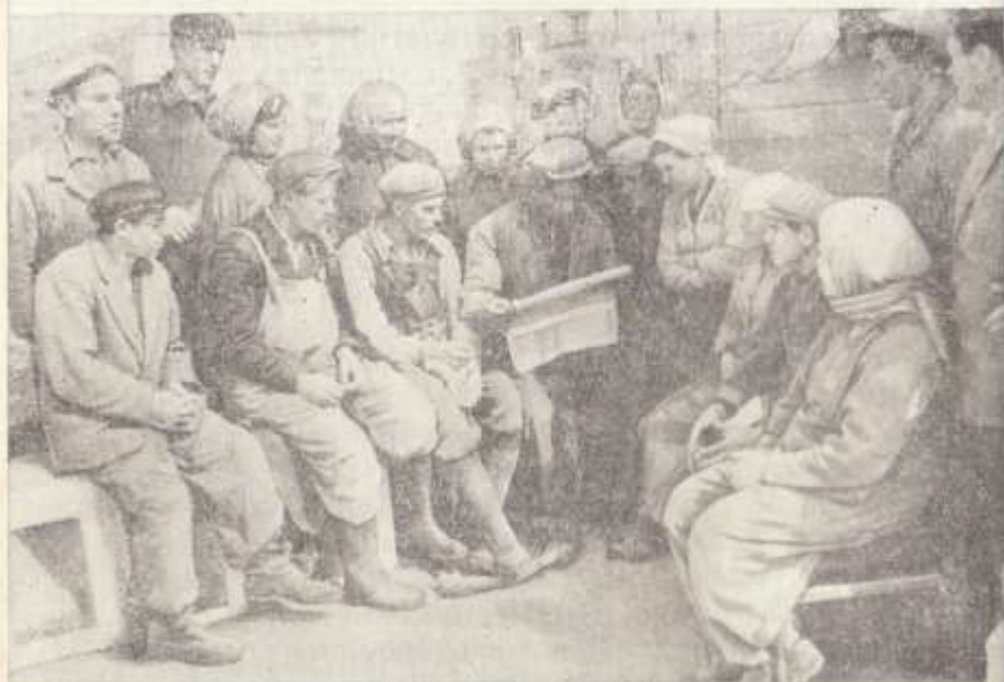
Трест Мосстрой № 1. Бригада коммунистического труда отдыхает
