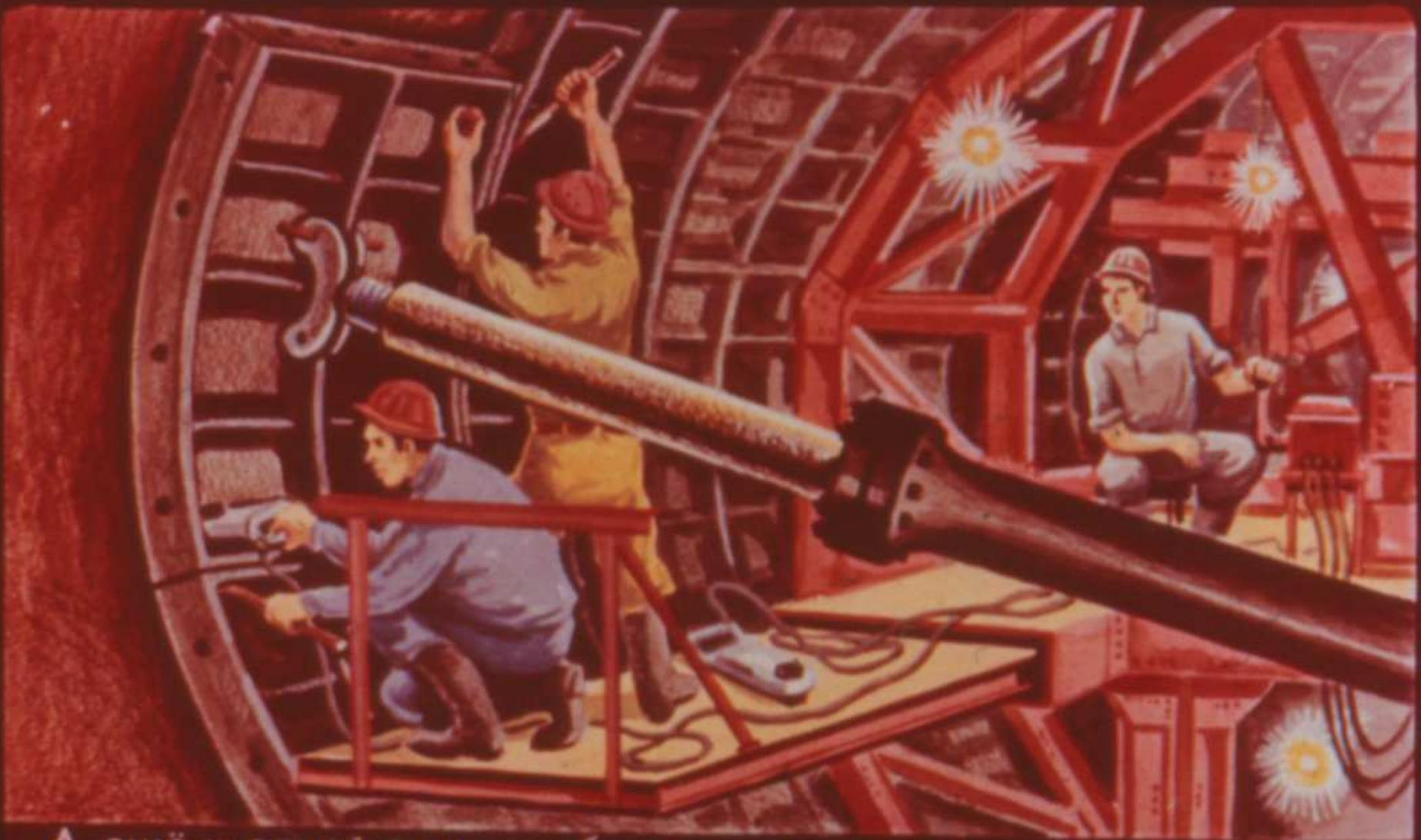
А **ещё** у одной машины была руна, совсем как живая. Эта рука приложила к подземной стене, к земле, какой-то кусок железа. Рабочие тут же привинтили новый кусок к железной трубе-туннелю.
