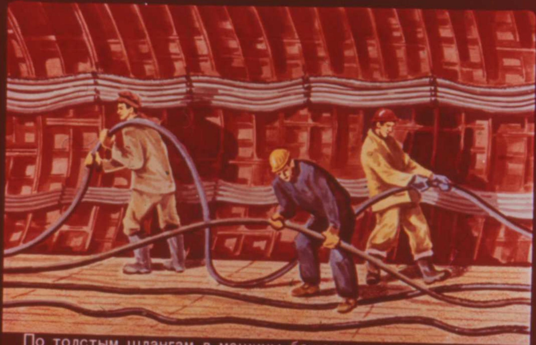
По толстым шлангам в машины бежал сжатый воздух, по проводам — электричество. Воздух и электричество давали машинам силу.
