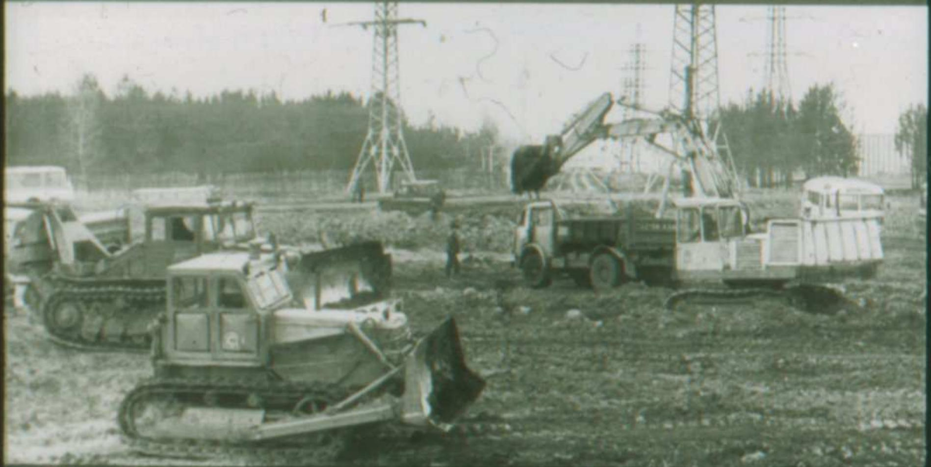
Затем экскаватор уступает место другой землеройной машине—БУЛЬДОЗЕРУ. Острый краем стального щита подрезает он бугры, засыпает ямы, разравнивает землю.
