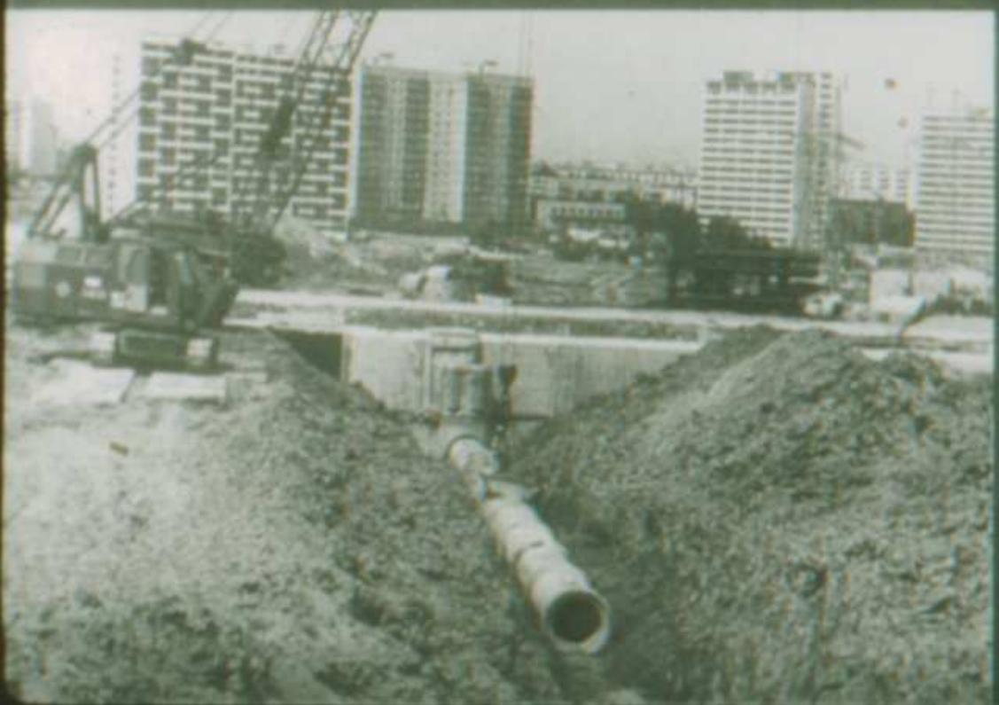
Первым делом к месту строительства прокладывают траншеи для труб. По ним в дом пойдет тепло, вода, газ...
