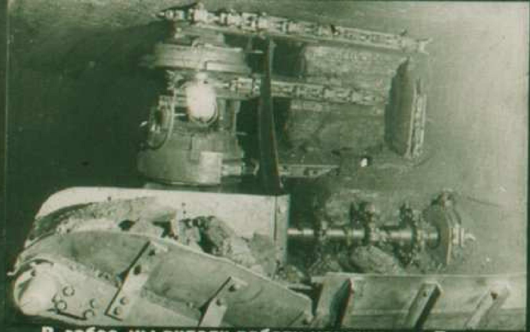
**В забое мы видели работу механизмов. Подземный комбайн сам врубается в пласт, загребает уголь и высыпает его на движущуюся ленту — транспортер.**
